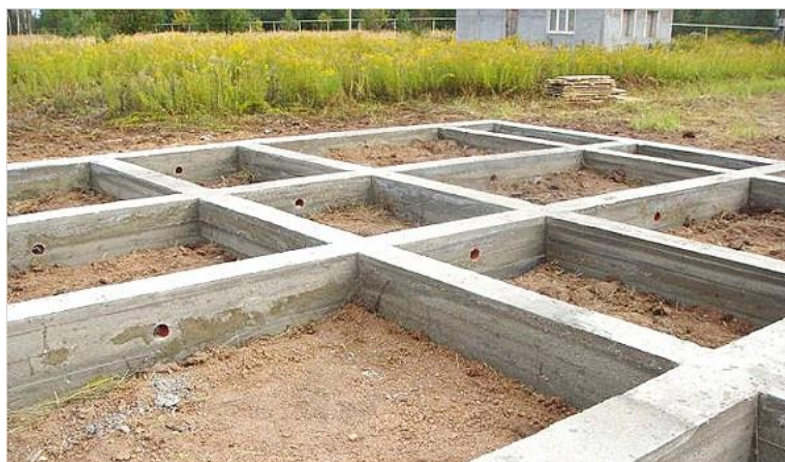
Рисунок 2. Монолитный ленточный фундамент
