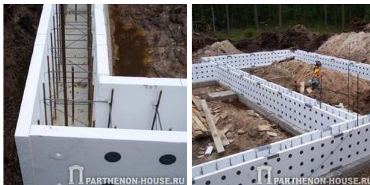
Рисунок 2 – Монтаж элементов несъемной опалубки PLASTBAU®
