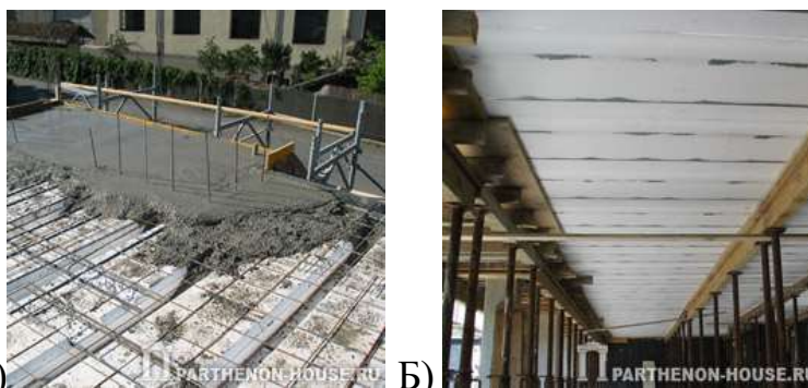
Рисунок 3 – А) Монтаж и бетонирование элементов перекрытия несъемной опалубки; Б) Опоры перекрытий несъемной опалубки
