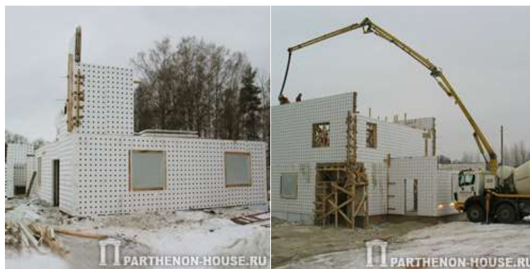
Рисунок 1 – Строительство дома из несъемной опалубки и бетонирование
